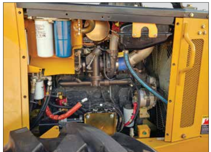
Ordentlicher, sauberer Motorraum mit schnellem Zugriff auf täglich zu wartende Bereiche.
