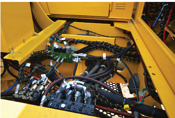
Все клапаны находятся под пешей платформой для обеспечения простого доступа к необходимым компонентам с аккуратно проложенными гидравлическими шлангами и электрическими проводами.
