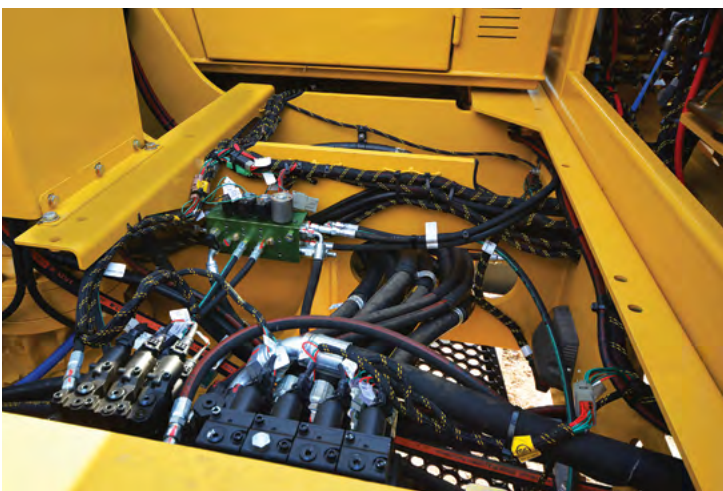
Все клапаны находятся под пешей платформой для обеспечения простого доступа к необходимым компонентам с аккуратно проложенными гидравлическими шлангами и электрическими проводами.
