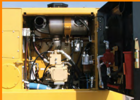
Acceso a las bombas y filtros desde la altura de trabajo.
